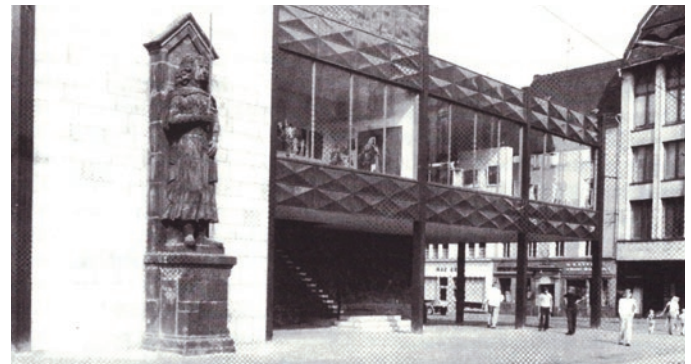
Roter Turm, Umbauung mit dem Standbild des Roland aus: Dolgner et al. (2002): S. 178 (Archiv der Hochschule Burg Giebichenstein).
